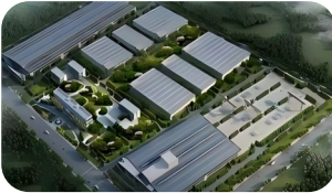
赣州新能源基地 30GWh
