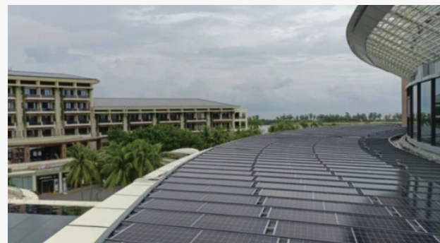
17级台风过境后隆基光伏组件
