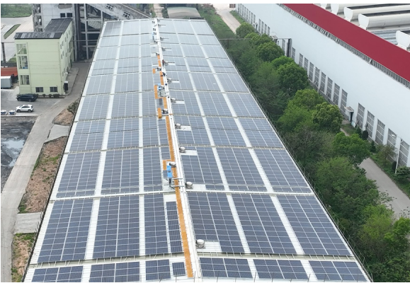
屋面光伏板铺设
