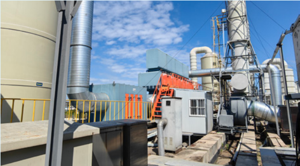
废气吸附催化燃烧处理改造项目
