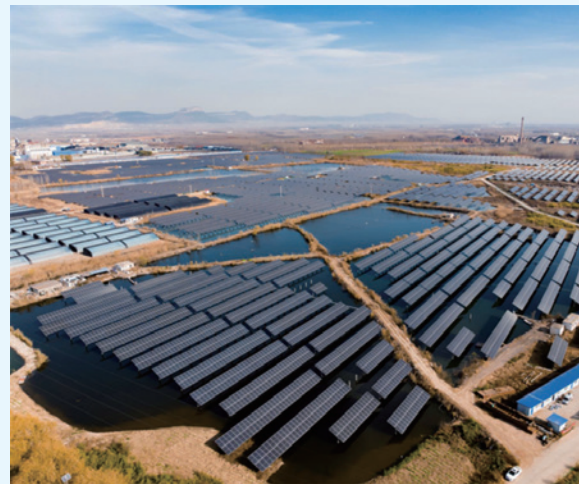
山东肥城石横镇渔光互补项目
