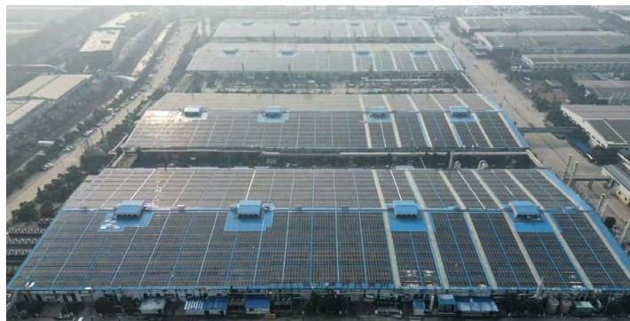
济源园区光伏
