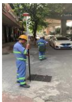
GNSS RTK 测量现场
