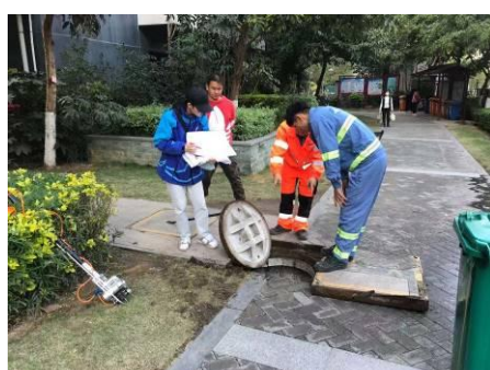
思明区管道探测现场
