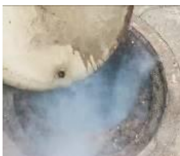
烟雾试验现场
