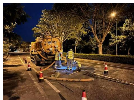
思明区项目作业现场
