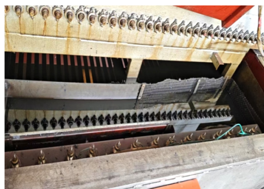
淬火油冷却槽加装过滤网回收
