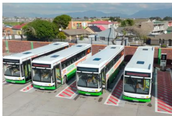
南非开普敦电动公交充电枢纽
