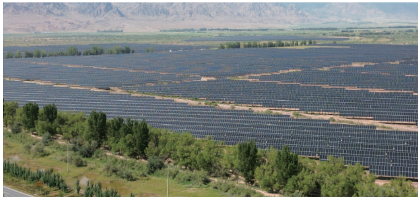
中环新能源内蒙古光伏治沙项目
