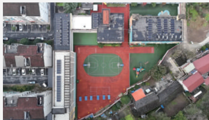
佛坪县长角坝镇小学光伏屋顶
