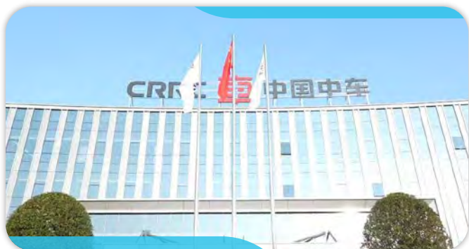
中低压功率器件产业化（株洲）建设项目
