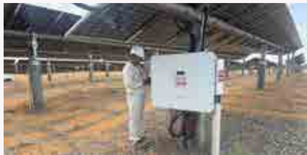
现场调试与维护
