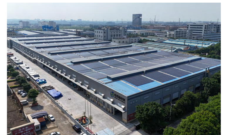
经纬新材料光伏发电项目
