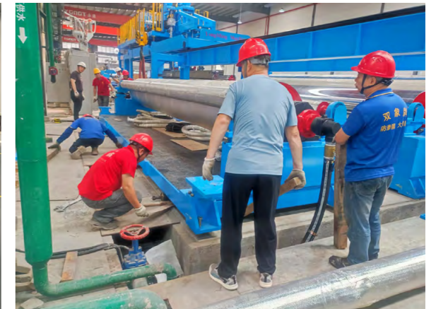
经纬新材料高新复合阻隔材料升级扩产项目设备安装调试
