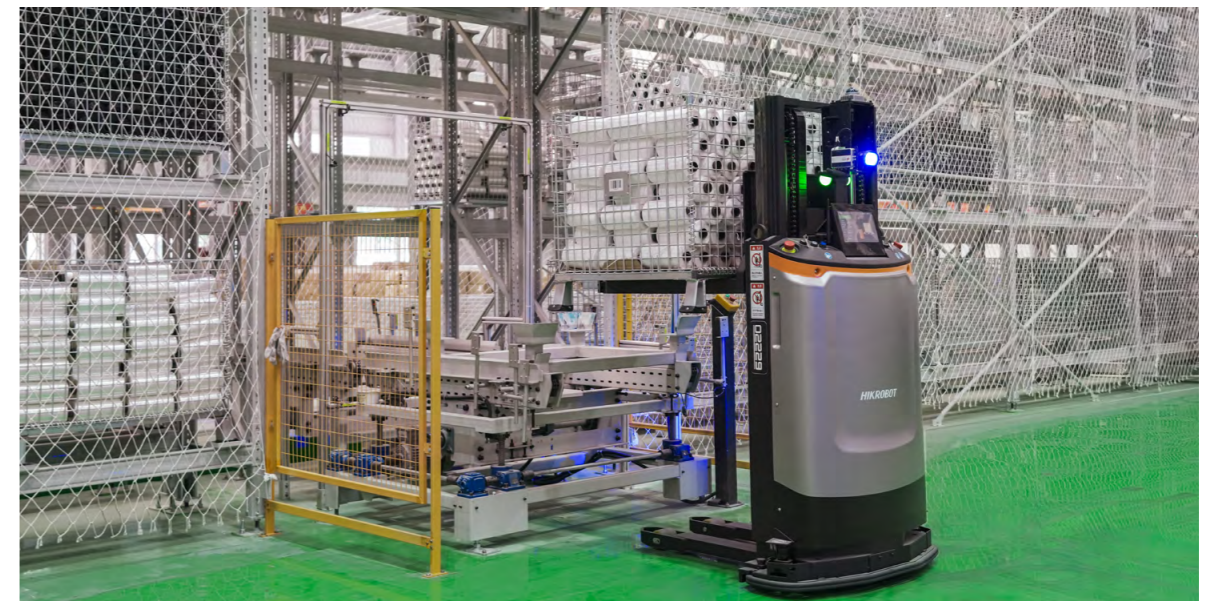
经纬新材料立体仓库和智能物流项目
