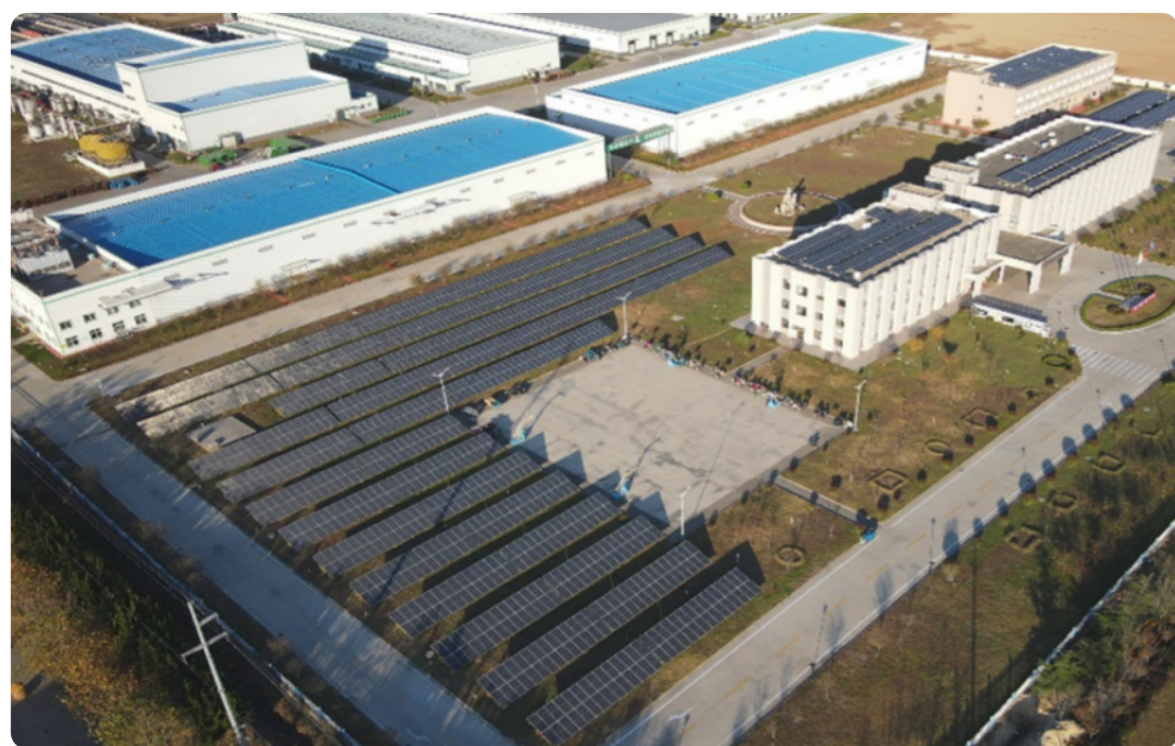
乳山工业园区的光伏电站
