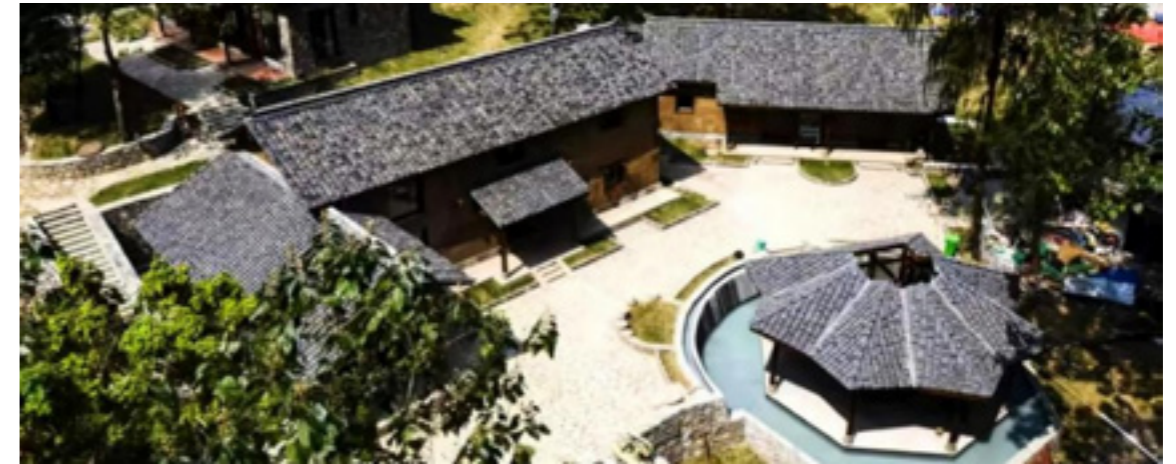
升级改造后的“下庄天路”景区
