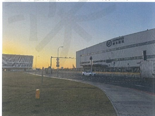
南侧临空港一道
