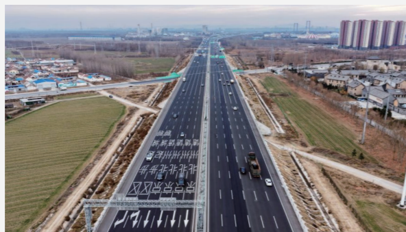
京台高速改扩建工程
