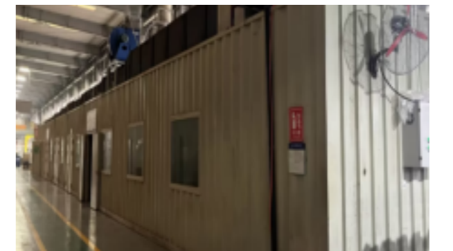
车间现场更换气板枪并隔音升级改造
