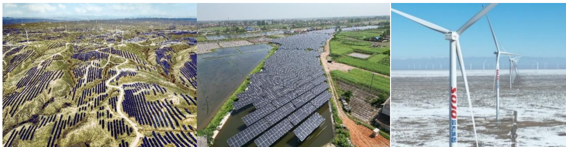
宁夏中卫光伏发电 EPC 工程
