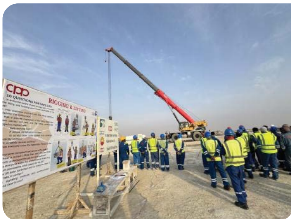
吊装安全现场实操演练
