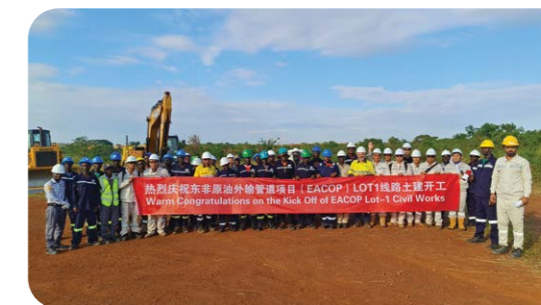
东非原油外输管道项目线路土建开工现场
