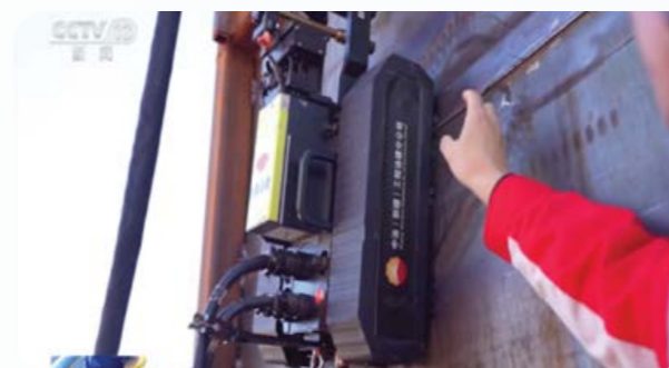
自主研发的储罐浮舱焊接机器人
