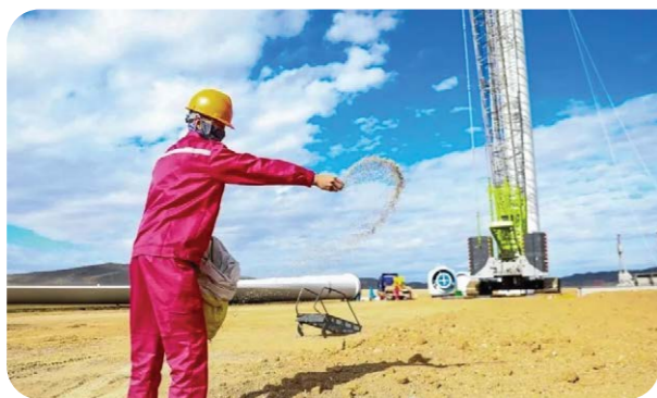
“土壤银行”施工现场
