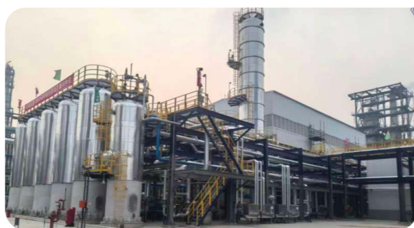
辽河石化公司制氢装置二氧化碳回收利用项目现场
