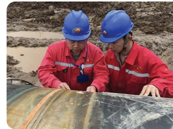
管道焊口检测现场
