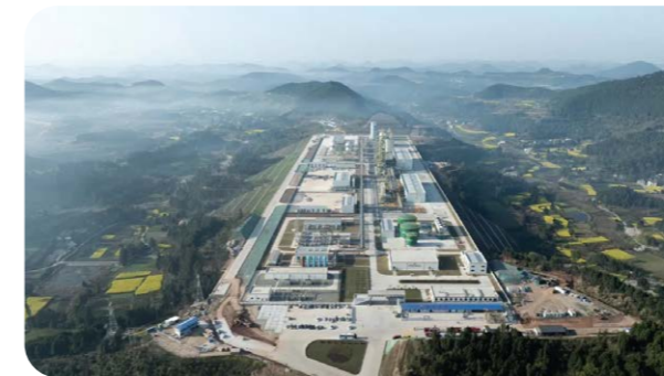
西南油气田盐亭天然气处理厂
