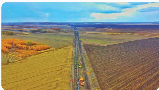
中俄东线天然气管道工程
