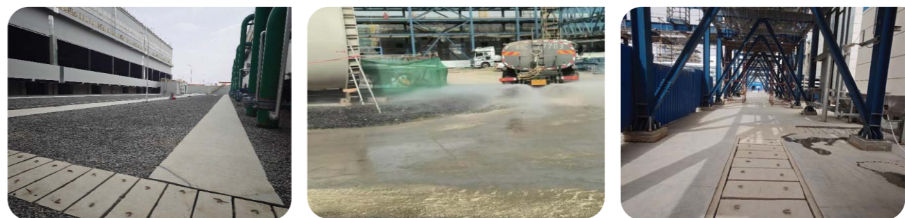
塔里木二期乙烯项目现场
