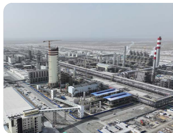
中国石油塔里木二期乙烯项目化肥装置现场
