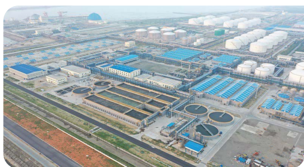
广东石化炼化一体化项目现场
