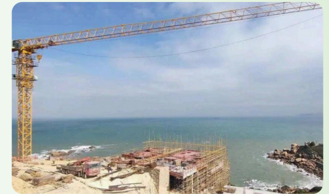
珠海东澳岛安麓酒店项目施工期间
