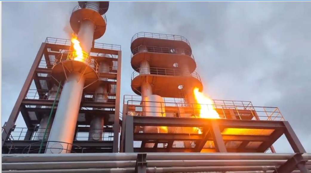
图 3 某基地真火项目交付验收现场
