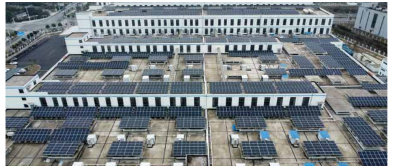
铺设光伏设施，用于办公区域的照明系统
