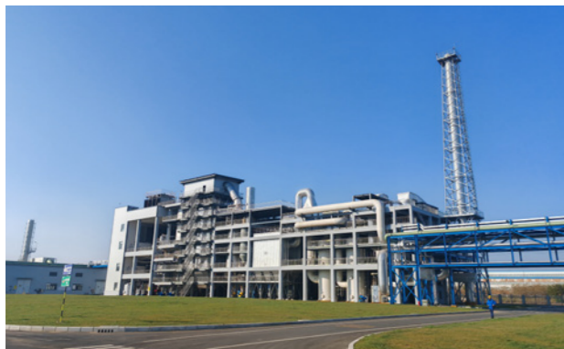
工厂焚烧装置
