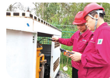
▲ 煤层气现场安全检测作业
