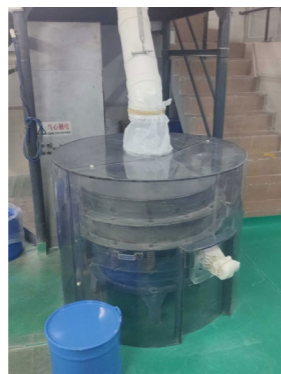
广州建丰九车间过筛机 加装隔音罩
