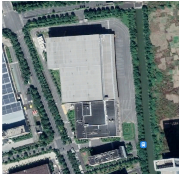
图注：母婴工厂屋顶光伏设备俯瞰图
