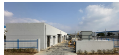
400T/D综合污水处理站
