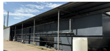
80T/D综合污水处理站
