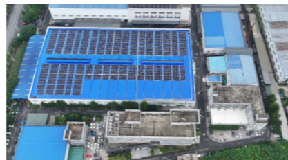
成都望锦光伏项目
