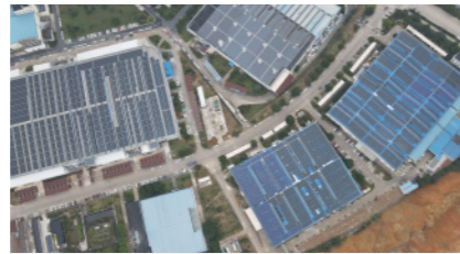
中鼎密封件南山园区光伏项目
