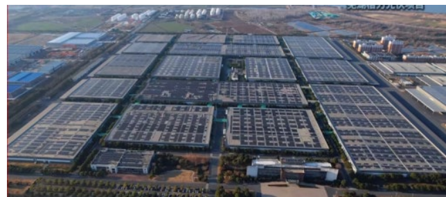
芜湖格力光伏项目
