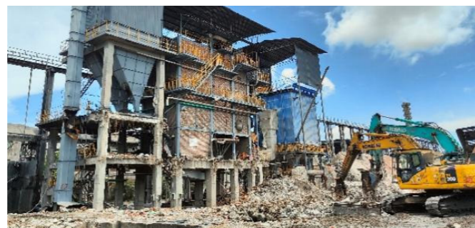
正在拆除的循环流化床锅炉
