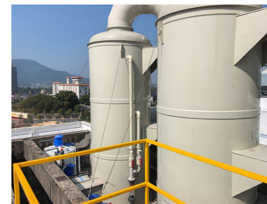
车间废气治理系统改造
