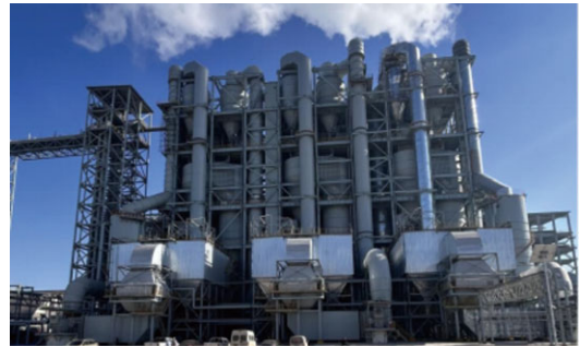
大型高效氧化鋁氣態懸浮焙燒爐
