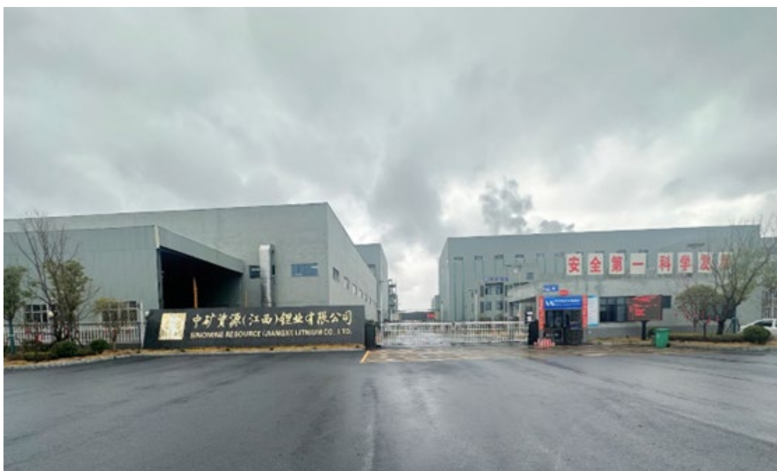
公司所属江西中矿锂业 3.5 万吨/年高纯锂盐工厂（二厂）
