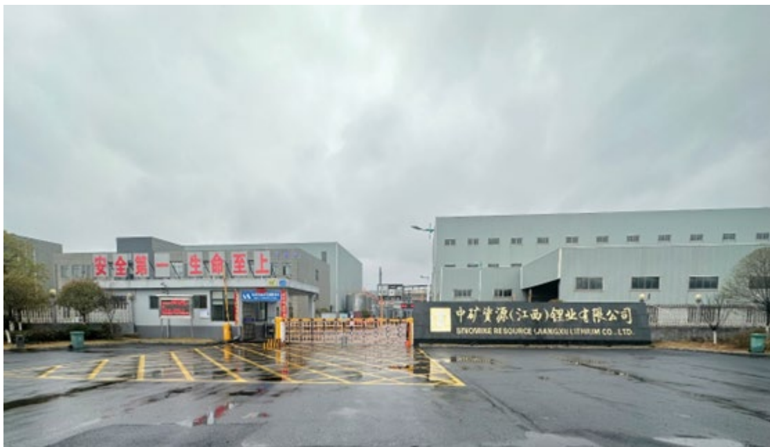
公司所属江西中矿锂业 3 万吨/年高纯锂盐工厂（一厂）
