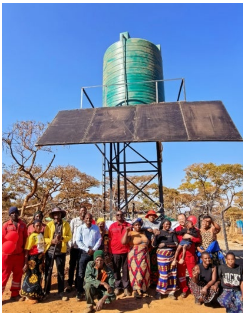
Kitumba 建成投用的供水深井
