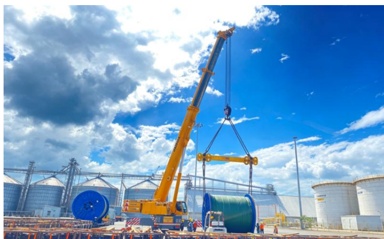
亨通墨西哥坎昆跨海岛屿电力海缆项目
