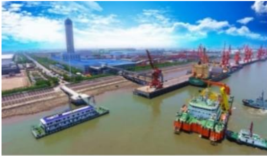
亨通国家电网舟山项目
