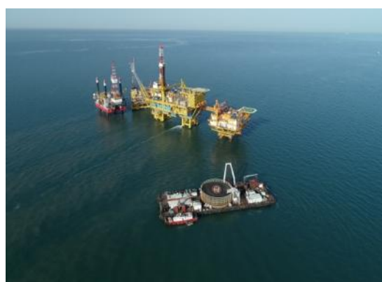
渤海秦皇岛-曹妃甸油田群岸电项目
